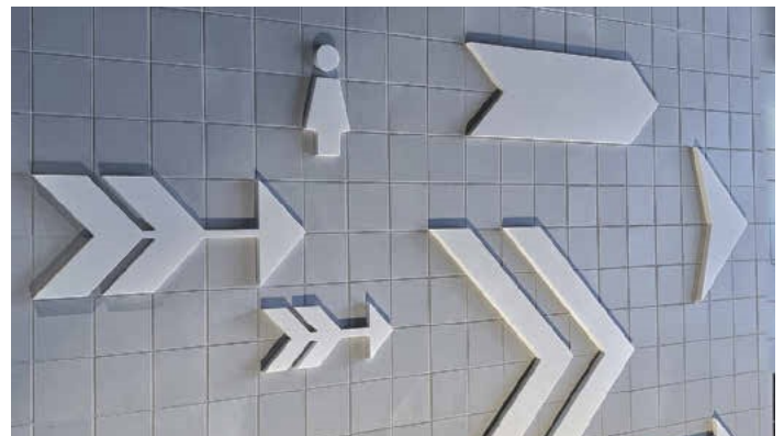
/ Reduziertes Leitsystem: Für die Beschilderung zu den Toiletten fertigte der Innenausbauer auf dem CNC-Bearbeitungszentrum Piktogramme aus Mineralwerkstoff.
