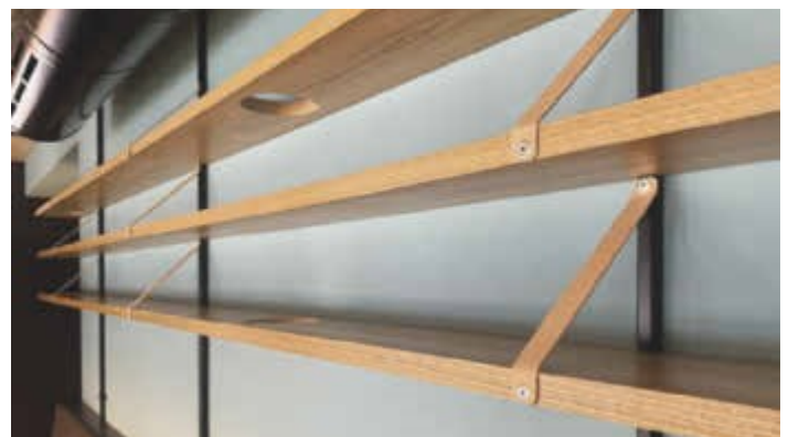
/ Unkonventionelle Aufhängung: Schwarz beschichtete Aluminiumrohre und Gurte aus Naturleder tragen die mit Pflanztöpfen bestückbaren Fachböden aus Kastanie.
