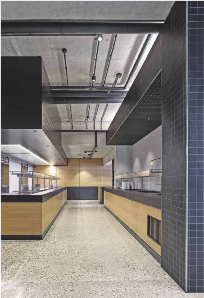
/ Sichtbar verlegte Elektro- und Lüftungsinstallations, grob geschalter Beton und geschliffener Estrich geben auch der Essensausgabe einen rauen Industrial Look.
