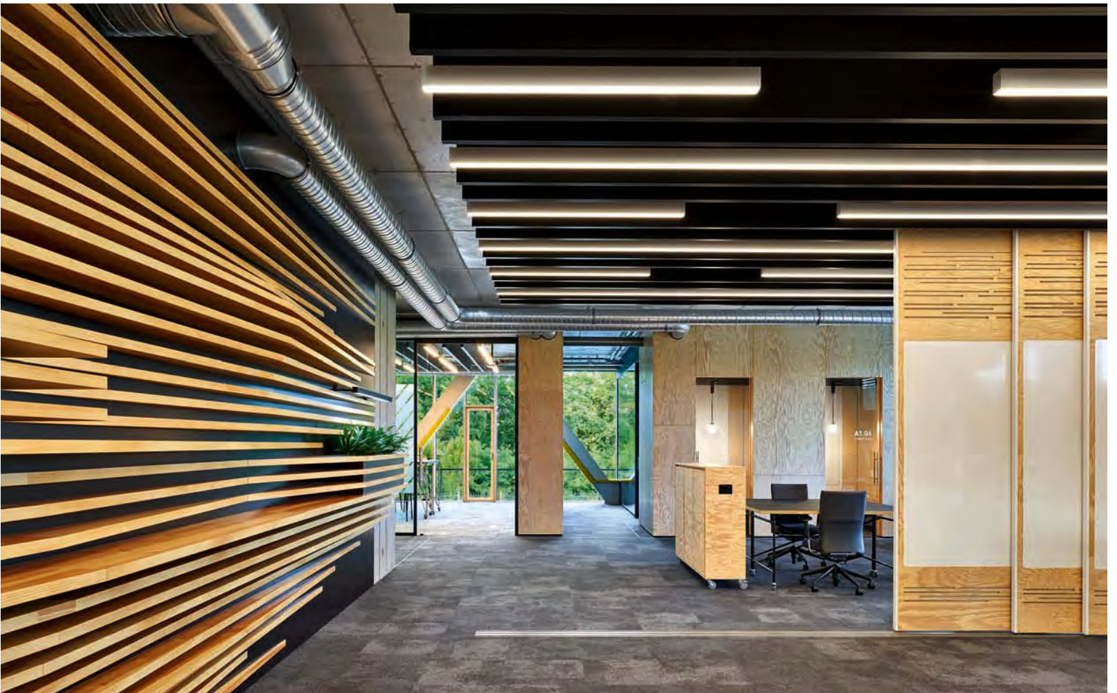
Der innen liegende Betonkern ist in den drei Obergeschossen mit akustisch wirksamen Lamellen verkleidet. • On the upper levels, the internal concrete core is clad with acoustically effective lamellas.
