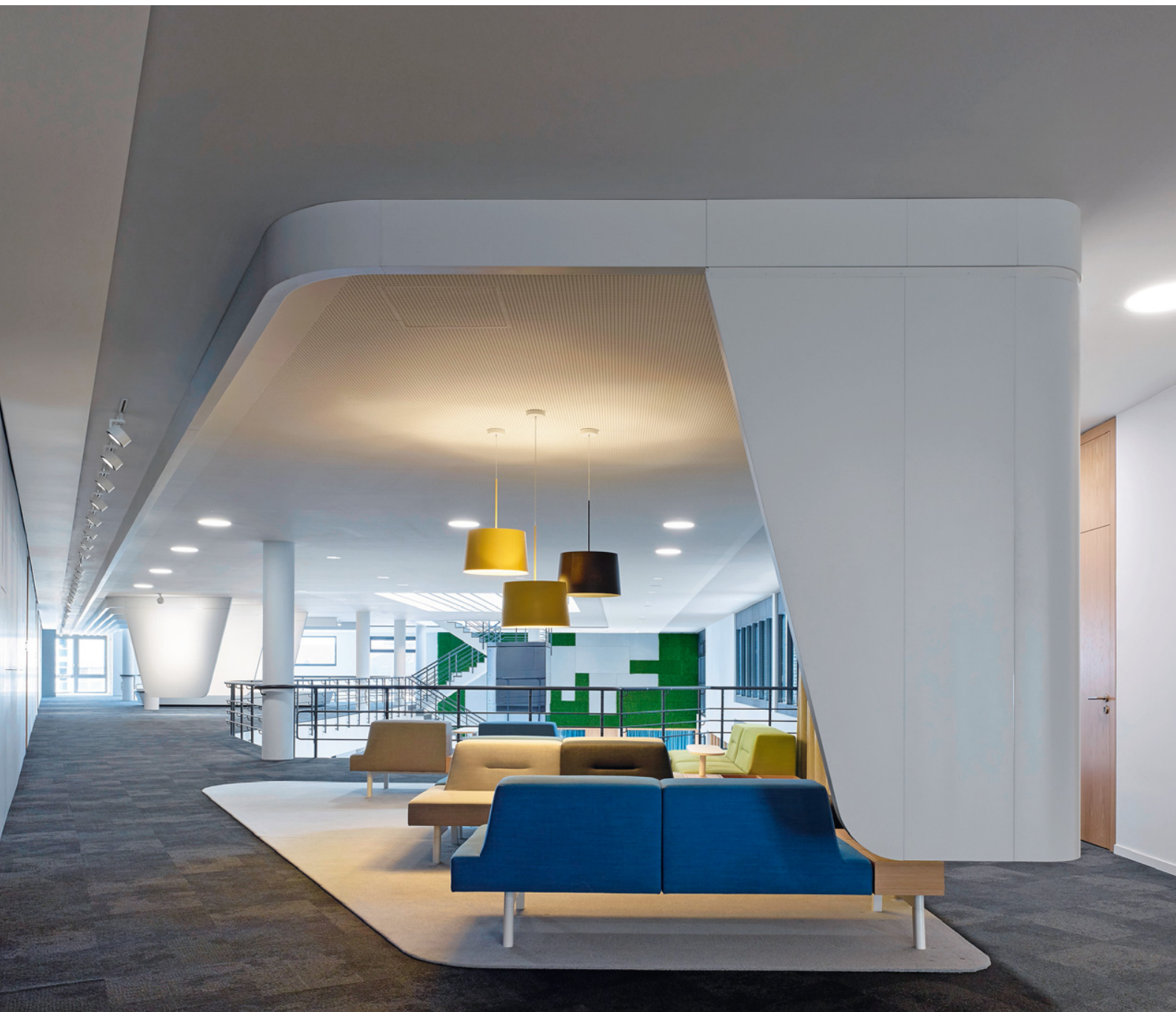
Die Galerieebene des Schulungszentrums: Die den Raum gliedernden, abgehängten Wandscheiben entwickeln sich aus den Bändern der Deckenkonstruktion
