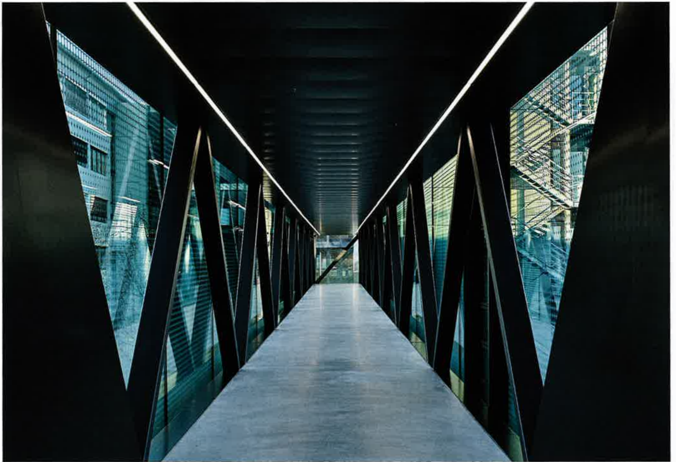
Stege verbinden die Bauteile untereinander und mit einem Bestandsgebäude.
